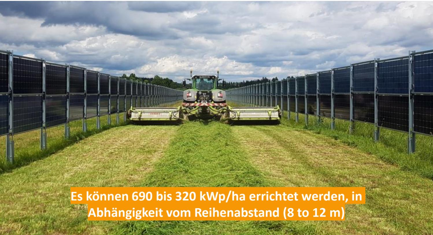
Es können 690 bis 320 kWp/ha errichtet werden, in Abhängigkeit vom Reihenabstand (8 to 12 m)
